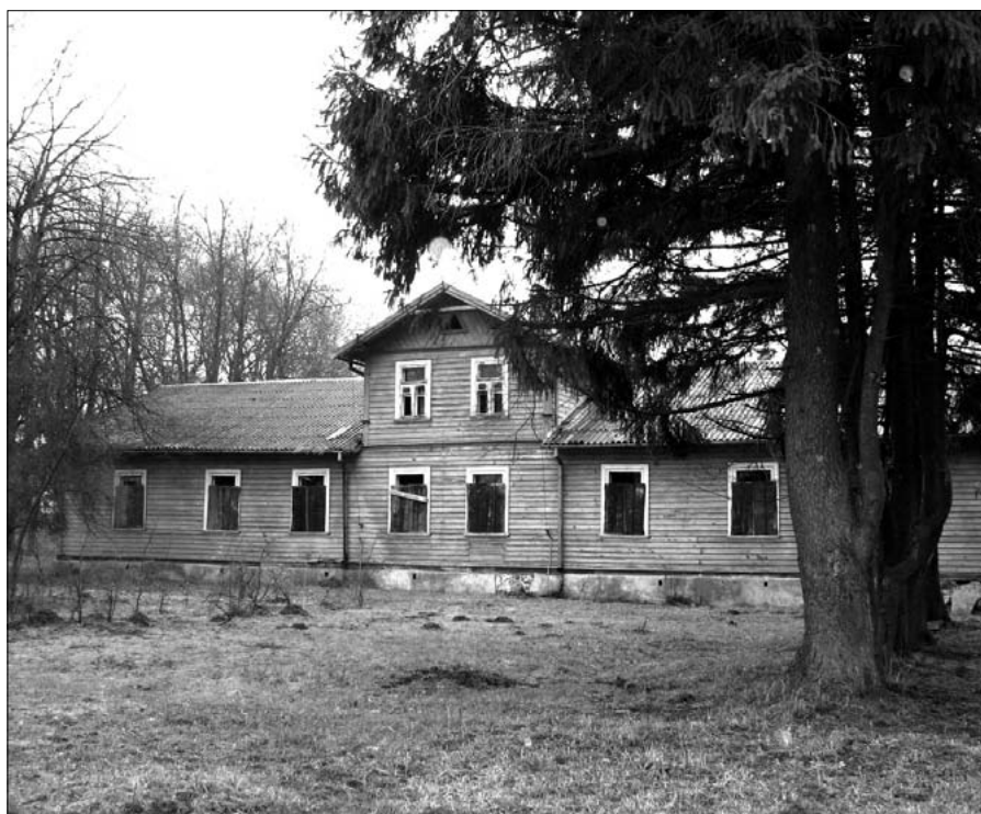
Elewacja ogrodowa. Stan obecny.
