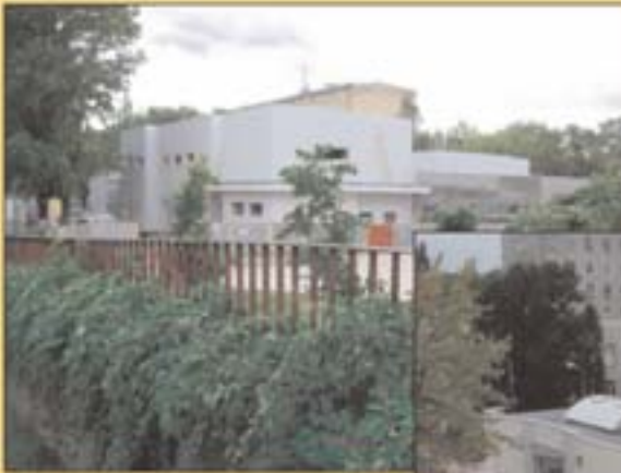
Budowa Centrum Medycyny Doświadczalnej AMB bliska zakończenia
