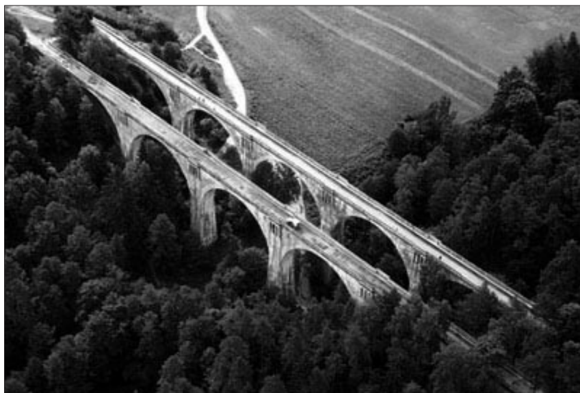
Zabytkowy most kolejowy w Kiepojciach.
