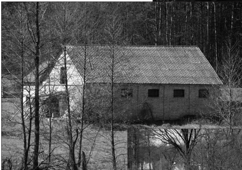
Murowana stajnia z XIX wieku. Stan obecny.
