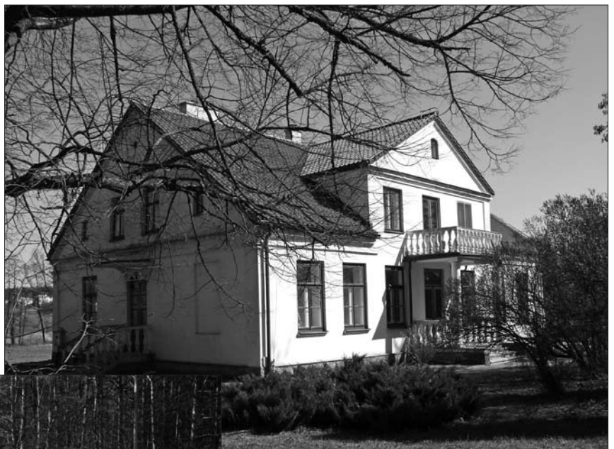
Elewacja frontowa dworu. Stan obecny.
