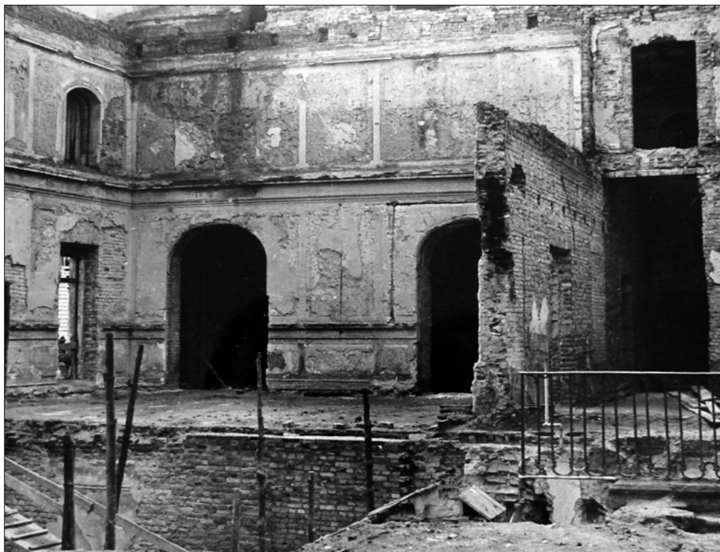
Dawna sala balowa na I piętrze. Stan przed odbudową 1948r. Fot. W. Paszkowski.
