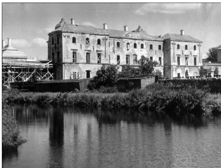
Pałac w trakcie odbudowy. Zbiory Biblioteki AMB f. 342.
