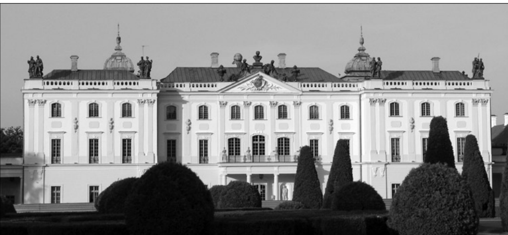
Pałac Branickich od strony ogrodu. Stan obecny. Fot. M. Grassmann.
