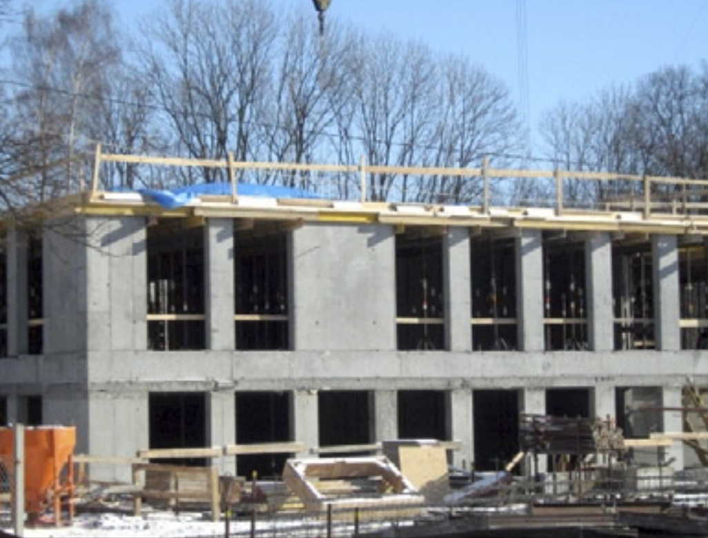
Budowa gmachu Wydziału Pielęgniarstwa.
