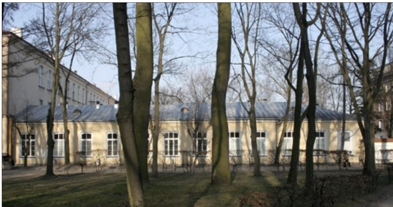
Siedziba Katedry Chemii, Analizy i Technologii Leków.
