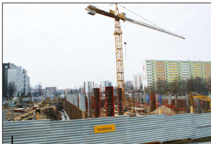
Nowy wielopoziomowy parking w budowie
