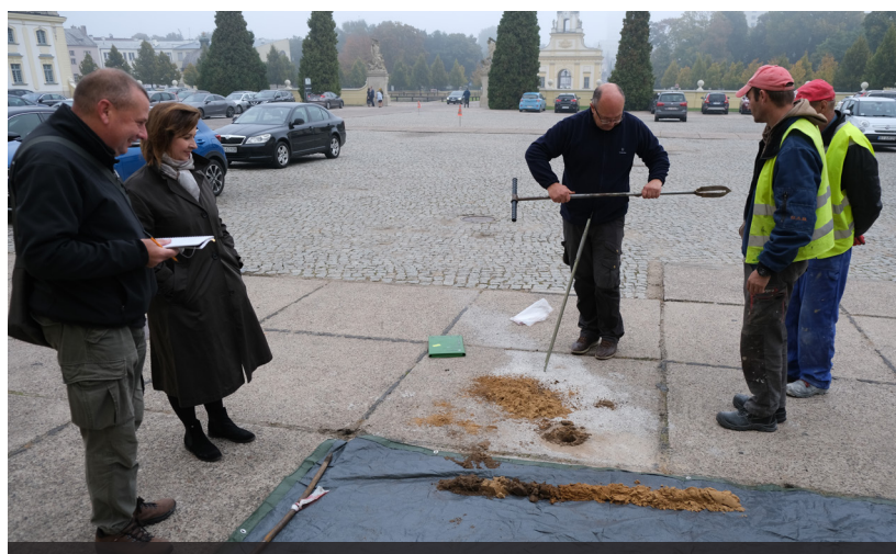
Odwierty sprawdzające strukturę ziemi na pałacowym dziedzińcu
