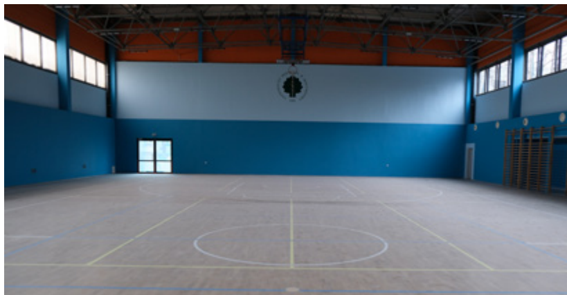
Wnętrze hali jest już praktycznie gotowe
