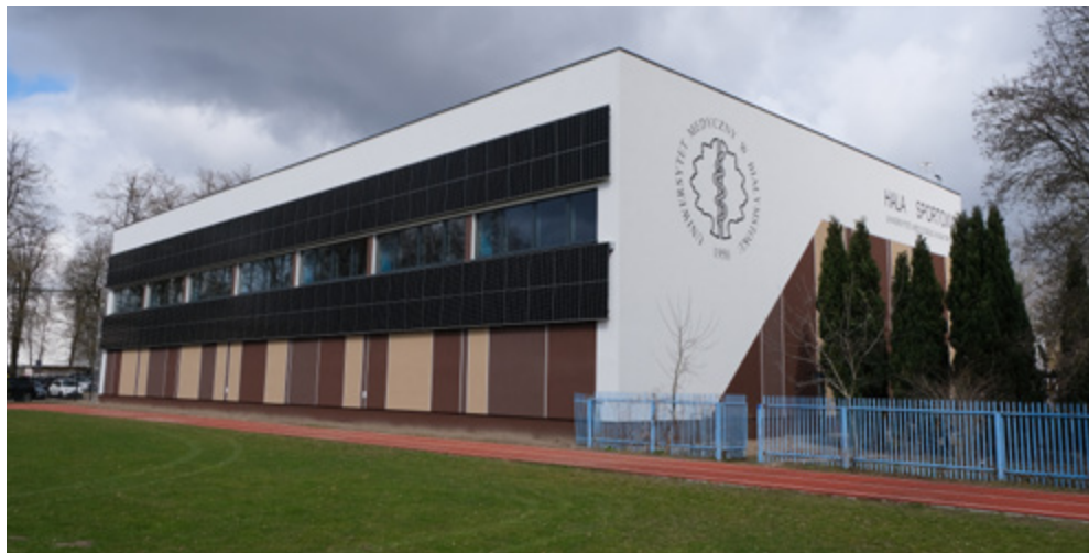
Nowa elewacja hali wraz z panelami fotowoltaicznymi, fot. Wojciech Więcko
