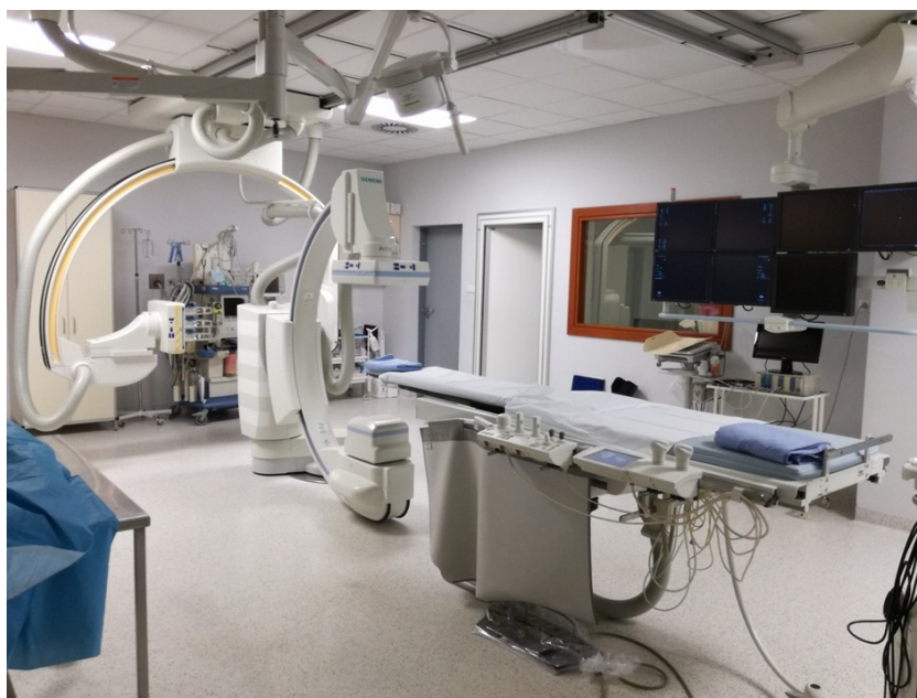
Fotografia 5. Pracownia radiologii zabiegowej Uniwersyteckiego Szpitala Klinicznego w Białymstoku (zdjęcie własne)
