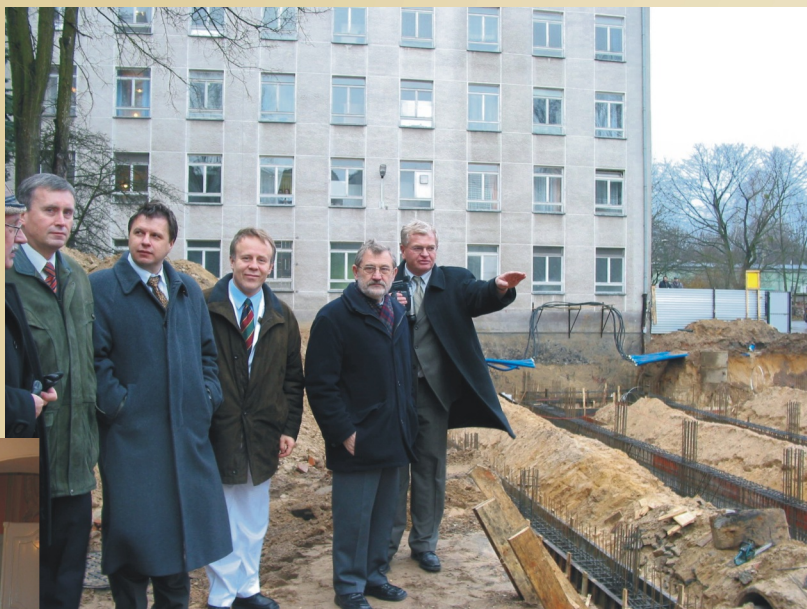
Budowa została rozpoczęta
