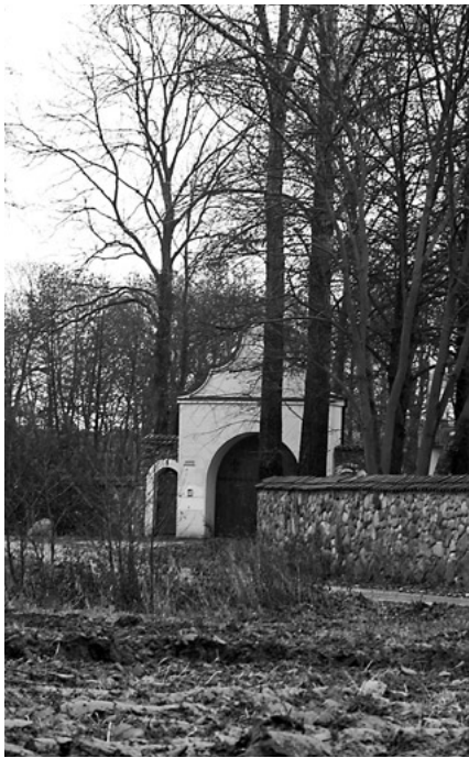
Brama wjazdowa do majątku Bogdaniec. Stan obecny.
