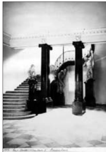
Fot. Odarta z dekoracji klatka schodowa w pałacu. Rok 1914.
