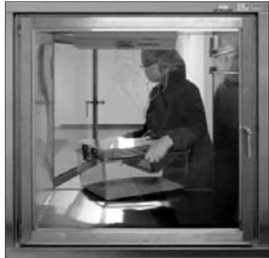
Fot. Okno podawcze oddzielające strefę.
