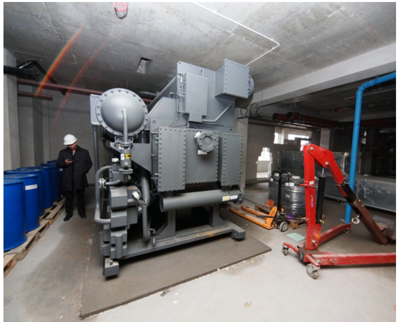
Rozbudowa szpitala. U góry nowatorski agregat produkujący chłód z gorącej pary wodnej. U dołu - nowy szpitalny hol
