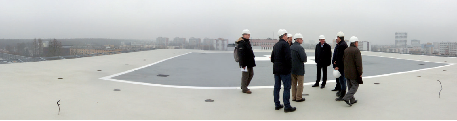
Podgrzewane lądowisko dla śmigłowców na dachu szpitala |
