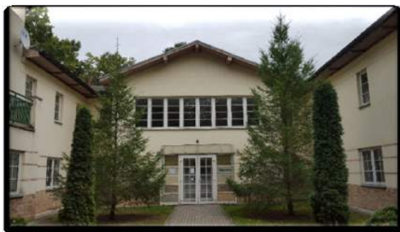
Zdj.64. Biblioteka- wejście
