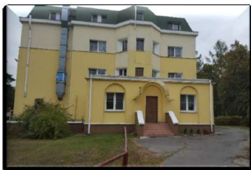
Zdj.60. Wejście do Domu Chłopców
