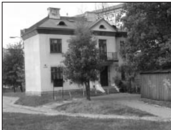
Stan obecny budynku przy ul. Waszyngtona 4B
