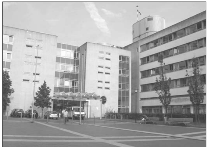
W budynku II Centrum Chirurgicznego Szpitala Uniwersyteckiego w Essen mieszczą się Kliniki: Chirurgii Urazowej, Chirurgii Ogólnej i Transplantacyjnej, Ortopedii, Chirurgii Klatki Piersiowej, Serca i Naczyń. Na dachu znajduje się lądowisko dla helikopterów.
