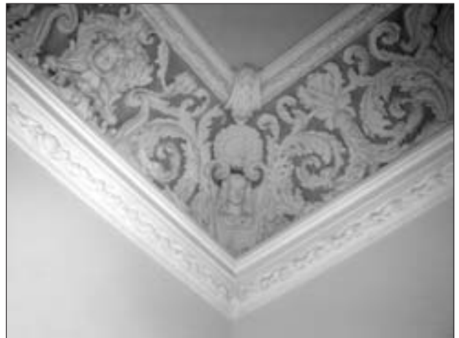
Fot. Fragmenty sztukaterii z czasów przebudowy pałacu w latach 90-tych XVII wieku w gabinecie rektora (dawne Pokoje Złote).
