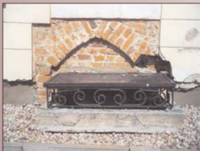
Magdalena Grassmann odkrywa sekrety pałacu Branickich. Fot. Gotyckie okno piwniczne, widoczne na elewacji od strony ogrodu
