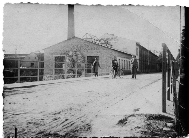
Szkoła Rzemieślniczo-Przemysłowa przy ul. Antoniukowskiej, 1930 r.
