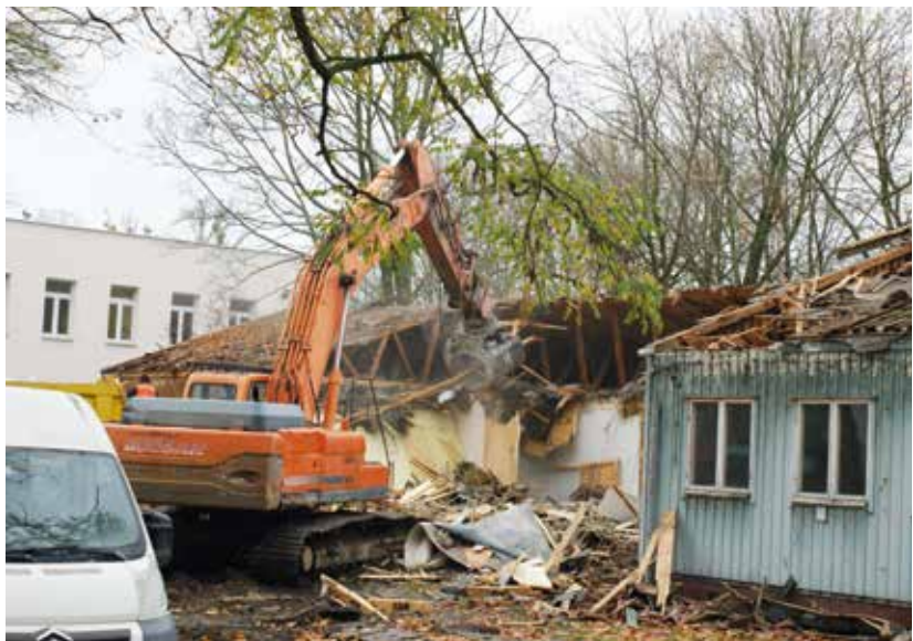
... i w trakcie rozbiórki, fot. Wojciech Więcko
