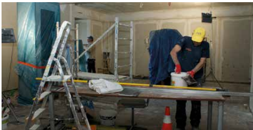
Remont w holu głównym, fot. Wojciech Więcko
