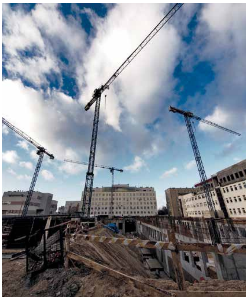
2011 r. - po trzech latach przygotowań i prac projektowych - rusza rozbudowa szpitala USK
