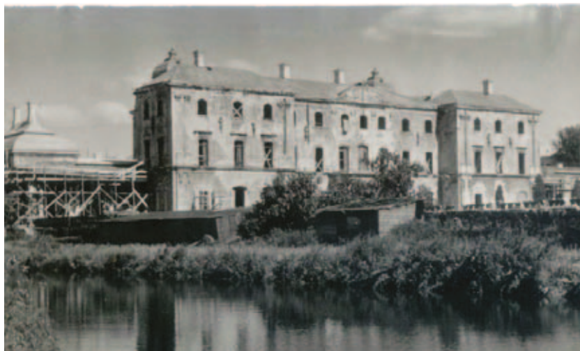
Odbudowa Pałacu Branickich po II wojnie światowej, fot. Archiwum UMB
