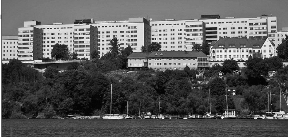
Nowoczesny szpital, którego większa część znajduje się pod ziemią. Widok ze statku spacerowego.
